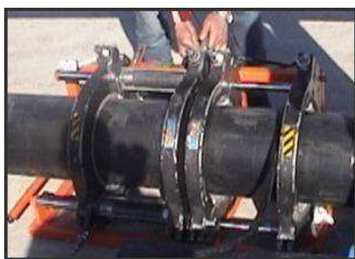
Proceso de pegado de los tubos. Fuente: E.P Desarrollo Agrario y Pesquero.
